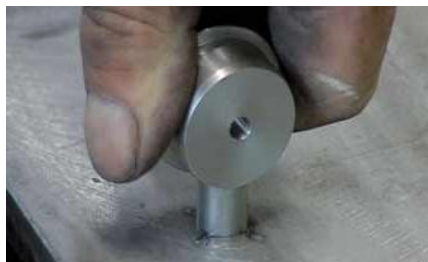
8. Treppentopf auf Gewinde M 12 x 1 aufschrauben 10 mm eindrehen ausrichten damit die Holzstufe auf den Treppentopf aufgesetzt werden kann.
