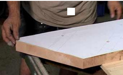
1. Bearbeiten der Stahlwange. Hilfsmittel Klebeschablone wird gleichzeitig für alle Einzelteile verwendet z.B. Stufen usw.
