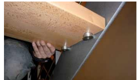
9. Vorgefertigte Holzstufe aufsetzen.
