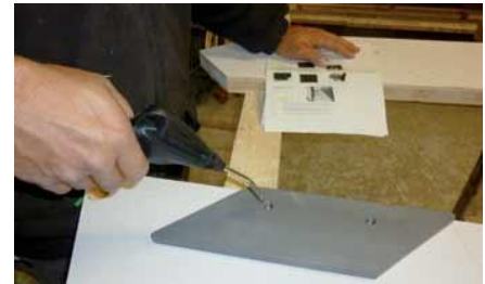
3. Bohrlöcher reinigen.
