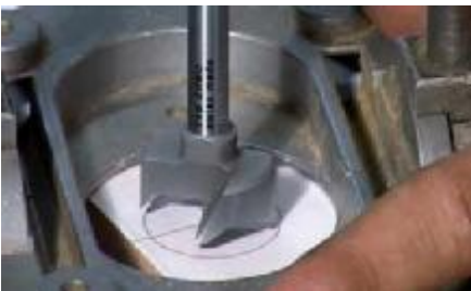
4. Holzstufe mit Forstnerbohrer Durchmesser 30 mm, 13 mm tief bohren und reinigen. Bei Verwendung einer 3,0 mm starken Dämmscheibe 15,5 mm tief bohren. Die Dämmscheibe sollte ca. 0,5 mm unter Spannung sein.
