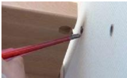
5. Injektionsmörtel WIT-VM 200 einspritzen.
