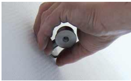
8. Treppentopf auf Gewinde M 12 x 1 aufschrauben 10 mm eindrehen ausrichten damit Stufe Treppentopf aufgesetzt werden kann.
