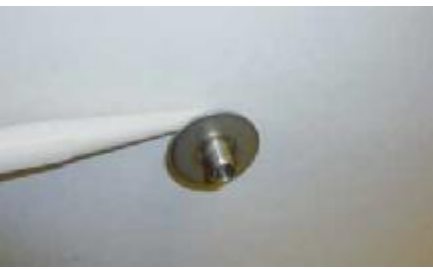
7. Abdeckscheibe auflegen und mit Silikon fixieren.
