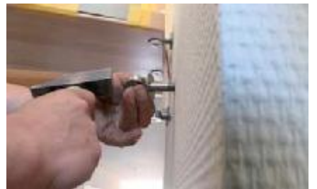
6. Gewindebolzen eindrücken, min. 78 mm, und ausrichten. Restlichen Mörtel entfernen.
