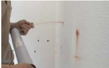
2. Bohrlöcher im Mauerwerk reinigen.
