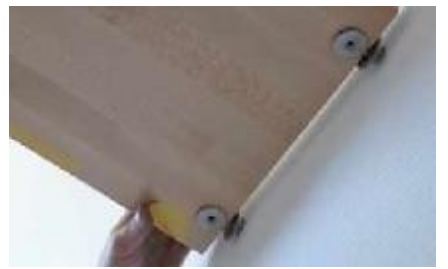
9. Vorgefertigte Holzstufe aufsetzen.
