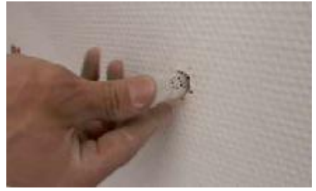
3. Siebhülse in Mauerwerk einlegen, bei Beton entfällt die Siebhülse.
