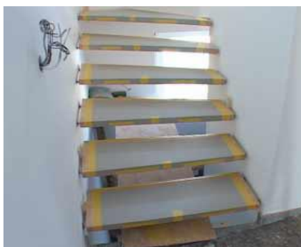
8. Treppentopf auf Gewinde M 12 x 1 aufschrauben 10 mm eindrehen ausrichten damit Stufe Treppentopf aufgesetzt werden kann.
