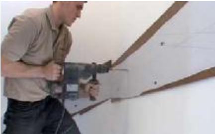
1. Vorbereiten des Mauerwerks bohren Durchmesser (Beton 14 mm, Mauerwerk 18 mm), Hilfsmittel Klebeschablone.
