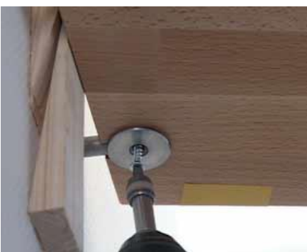
10. Treppentopf mit ASSY® Schraube 5 x 40 mm verschrauben
