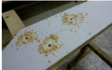
2. Kernloch für Gewindebolzen in die Holzwanen bohren, Bohrdurchmesser 10,5 mm.
