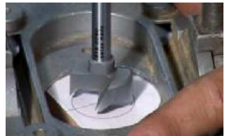
6. Holzstufe mit Forstnerbohrer Durchmesser 30 mm, 13 mm tief bohren und reinigen. Bei Verwendung einer 3,0 mm starken Dämmscheibe 15,5 mm tief bohren. Die Dämmscheibe sollte ca 0,5 mm unter Spannung sein.
