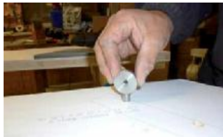
5. Treppentopf auf Gewinde M 12 x 1 aufschrauben, 10 mm eindrehen und ausrichten damit die Stufe auf den Treppentopf aufgesetzt werden kann.
