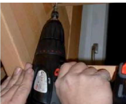
9. Treppentopf mit ASSY® Schraube 5 x 40 mm verschrauben
