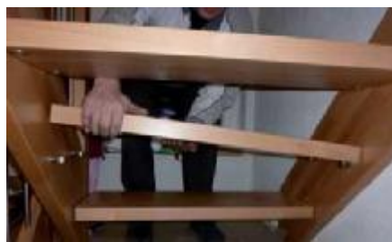
8. Vorgefertigte Holzstufe aufsetzen
