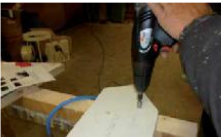
4. Gewindebolzen mit Inbusbit in Wange eindrehen, 30 mm tief.
