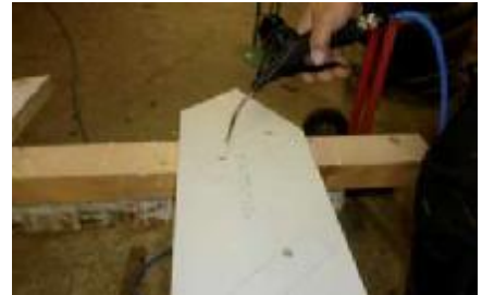
3. Bohrlöcher reinigen.
